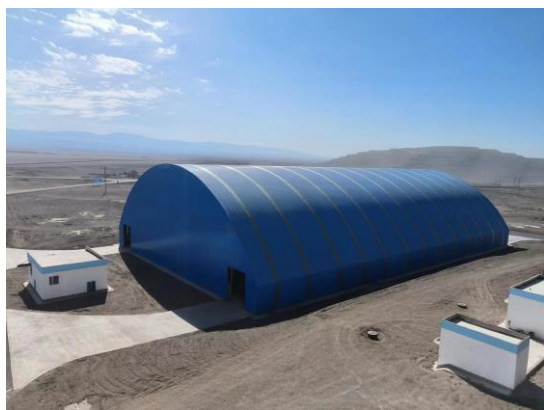
快装站密闭储棚
