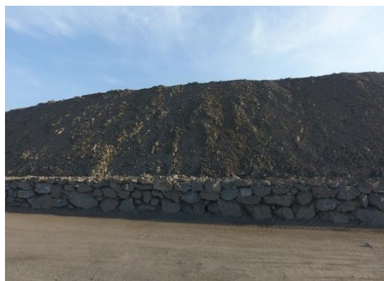
外排土场挡渣墙
