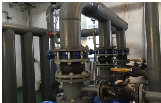
管道可曲挠橡胶接头
