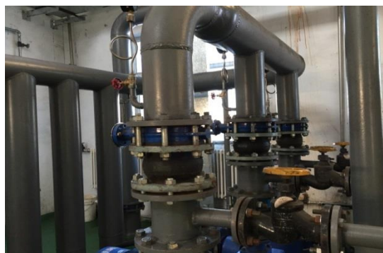
管道可曲挠橡胶接头
