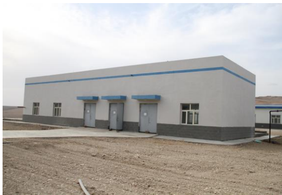
生活污水处理站
