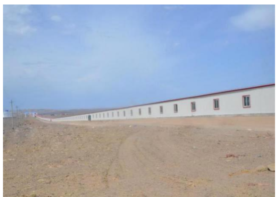
原煤输送栈道
