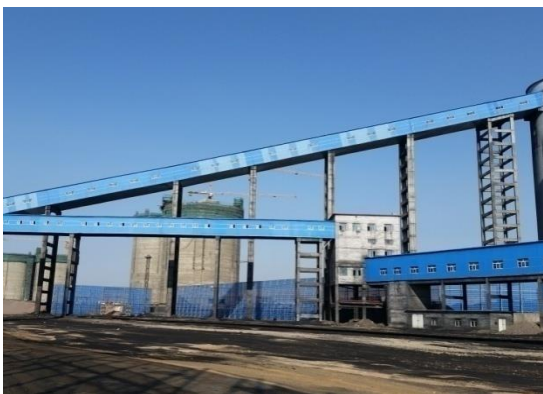
工业场地输煤栈道
