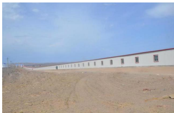
输煤皮带走廊
