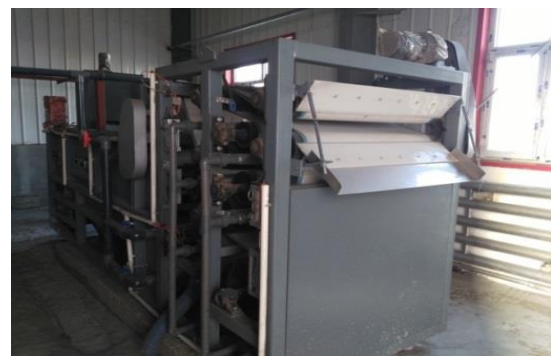
活性炭过滤罐
