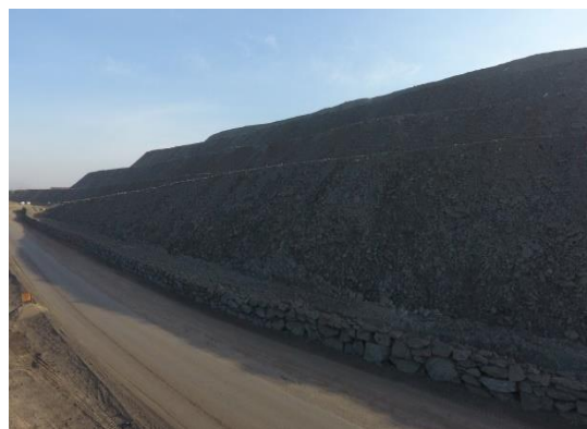
内排土场挡渣墙
